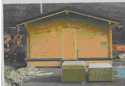
La struttura prefabbricata che ospiterà l'unità di rianimazione
